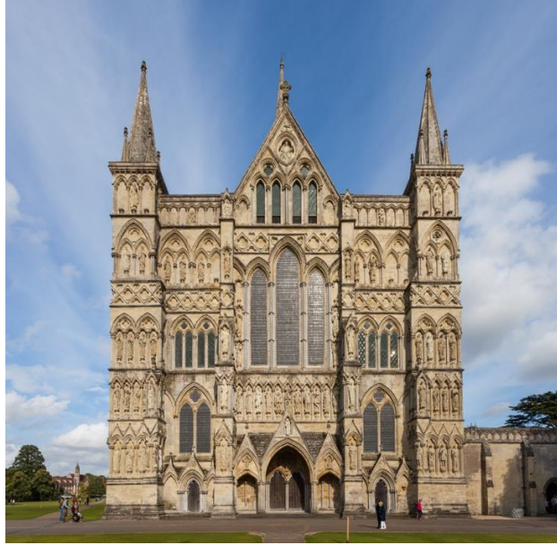
Görsel 1: Salisbury Katedrali Ön Cephe Görünüm
